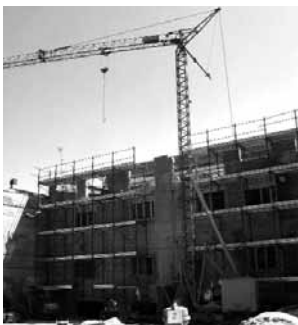
Il cantiere per la realizzazione del nuovo oratorio.
