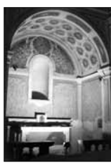
Una cappella in fase di restauro nella chiesa di Creta.
